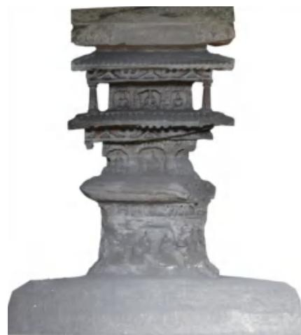
图2 数字图像纠偏技术生成的正射影像图
