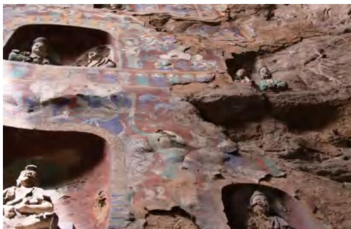
图3 壁画地仗层空鼓、剥离、脱落
