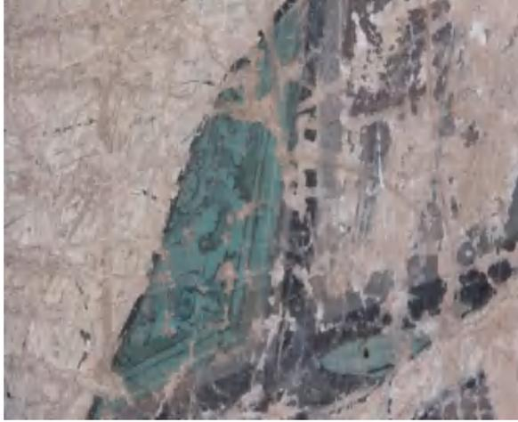
图5 壁画颜料层粉化、脱落病害
