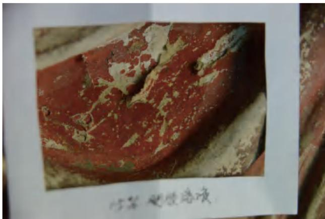
图 15 裱纸层起翘回帖加固前
