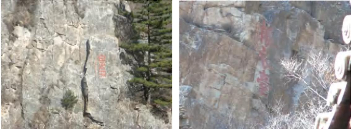
对于没有发生错位的题记，主要采用裂隙化学灌浆粘接的方法，只在必要的情况下设置小型锚杆，锚头必须做隐蔽处理，灌浆封护及注浆完成后，必须做旧平色。
