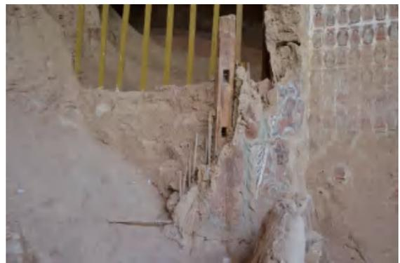
图6 炳灵寺第169窟塑像内部骨架
