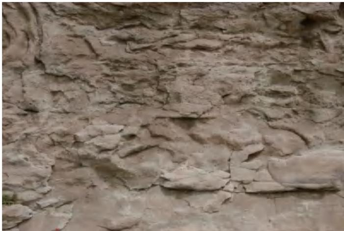
图5 云冈石窟片状风化砂岩
