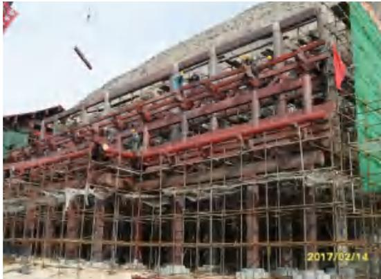
图 15 第 9、10 窟修建保护性窟檐大木构架安装现场
