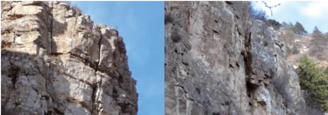
恒宗主殿东侧上部崖壁倾覆式破坏危岩体现状
