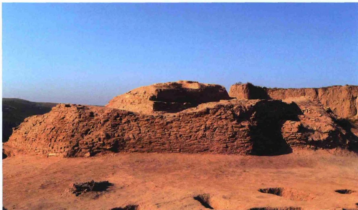
2. 塔基东部（东—西）
