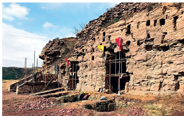
图26 加固维修中的鲁班窑石窟(来源:闫宏彬摄)
