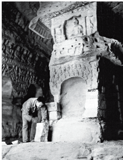
图24 1983年工人在第1窟中心塔柱 南面砌石(来源:赵岐摄)
